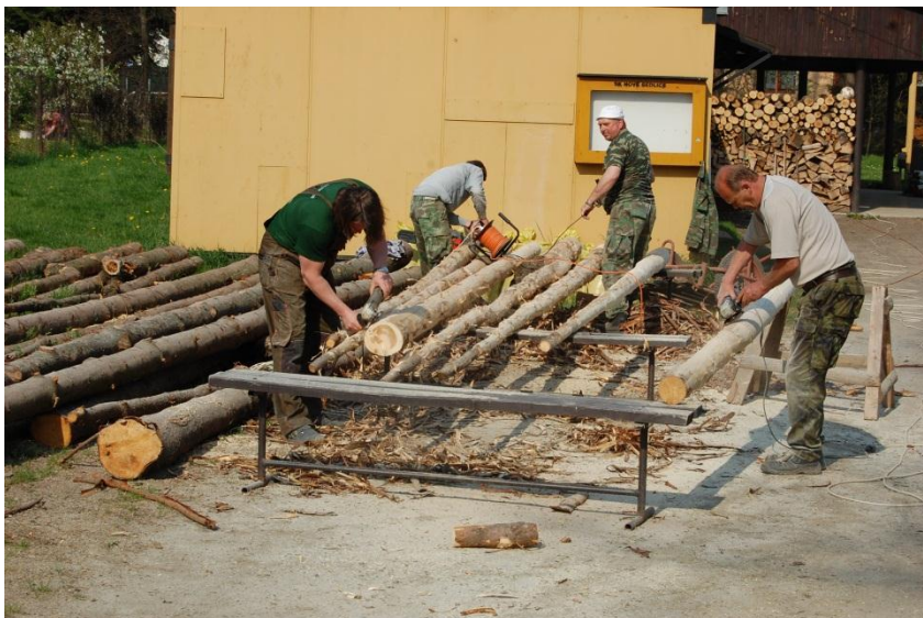
Příprava materiálu na průlezky
