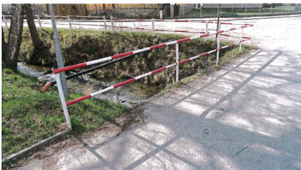
Pravé zábradlí – pohled od OP2.
