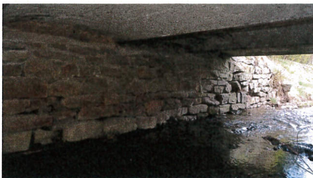
Pohled na OP1 a její levé křídlo K1L.
