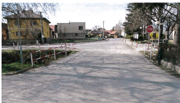
Pohled na most proti směru staničení od výtoku.
