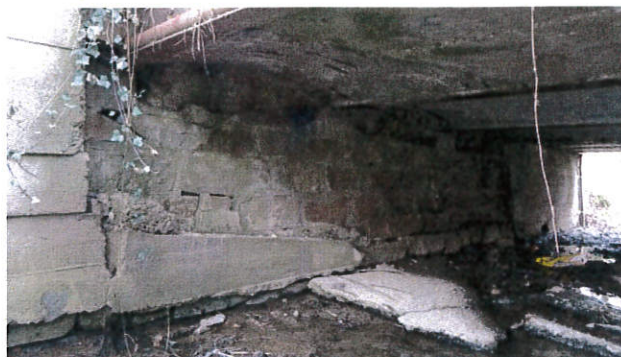
Levá původní kamenná opěra OP2.
