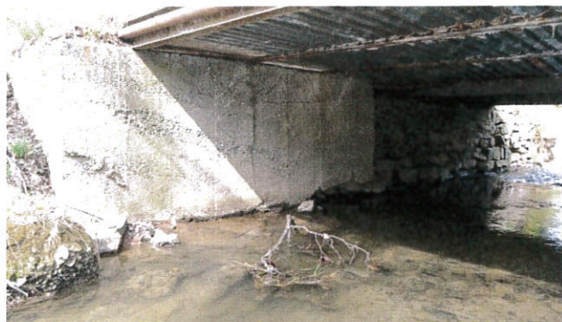
OP1 – rozšíření na pravé straně (na vtoku)
