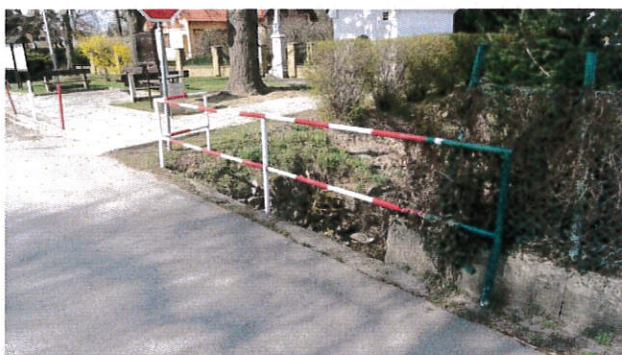
Levé zábradlí – pohled od OP2.
