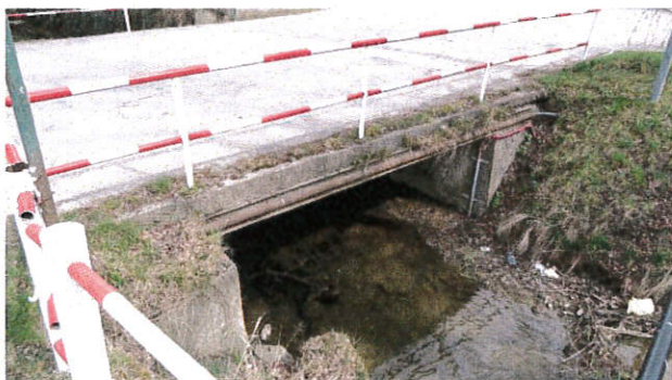
Pravé čelo mostu se zábradlím.
