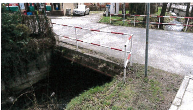
Levá strana mostu na výtoku.
