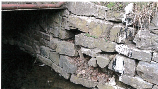
Dtto foto vedle. Další kameny kolem kaverny jsou uvolněné.
