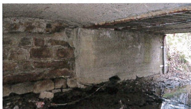
Rozšíření OP2 vpravo monolitickým betonem. Ve spodní části rozšíření je menší kaverna.
