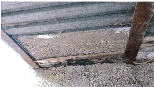
Detail foto vedle. Při betonáži byl trapézový plech nahrazen dřevěnou deskou.
