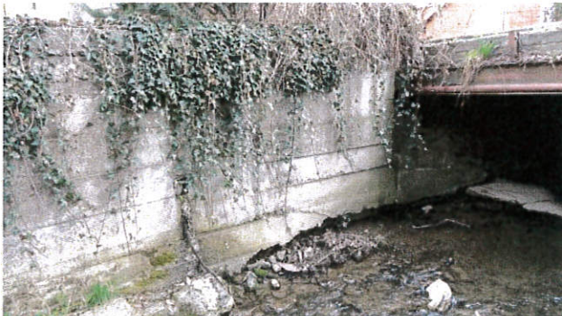
Levé křídlo OP2 – křídlo K2L
