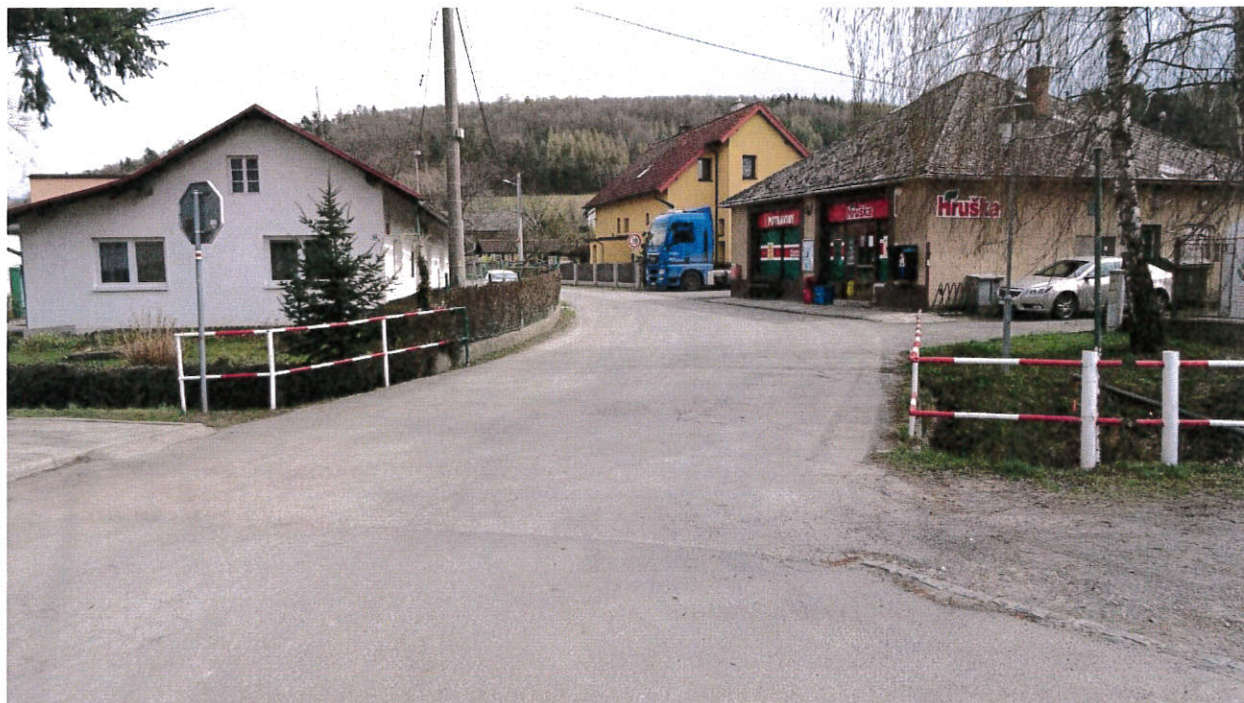
Pohled na most ve směru staničení (od hlavní silnice k obchodu). Vtok je vpravo.
