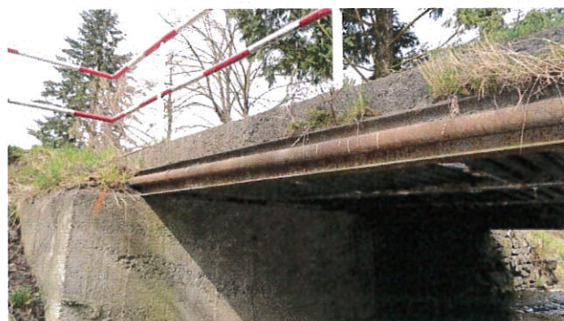
Pravý bok nosné konstrukce (NK) před OP1.
