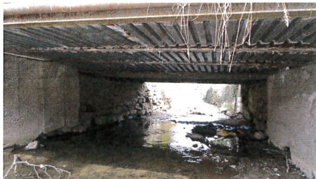
Pohled do mostního otvoru od vtoku (zprava).
