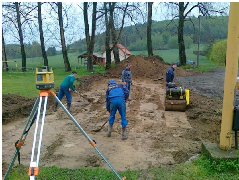
Příprava podloží pod zpevněnou plochu (4. 5. 2013)
