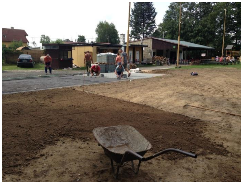
Kladení dlažby a terénní úpravy okolí plochy (24. 8. 2013)
