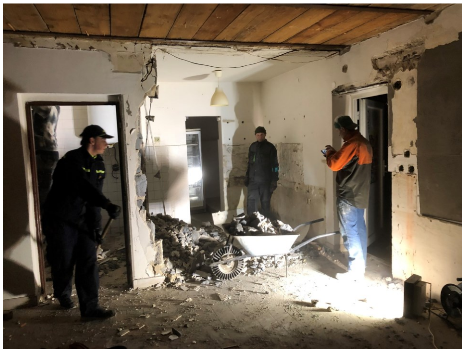
Bourací práce – březen 2019
