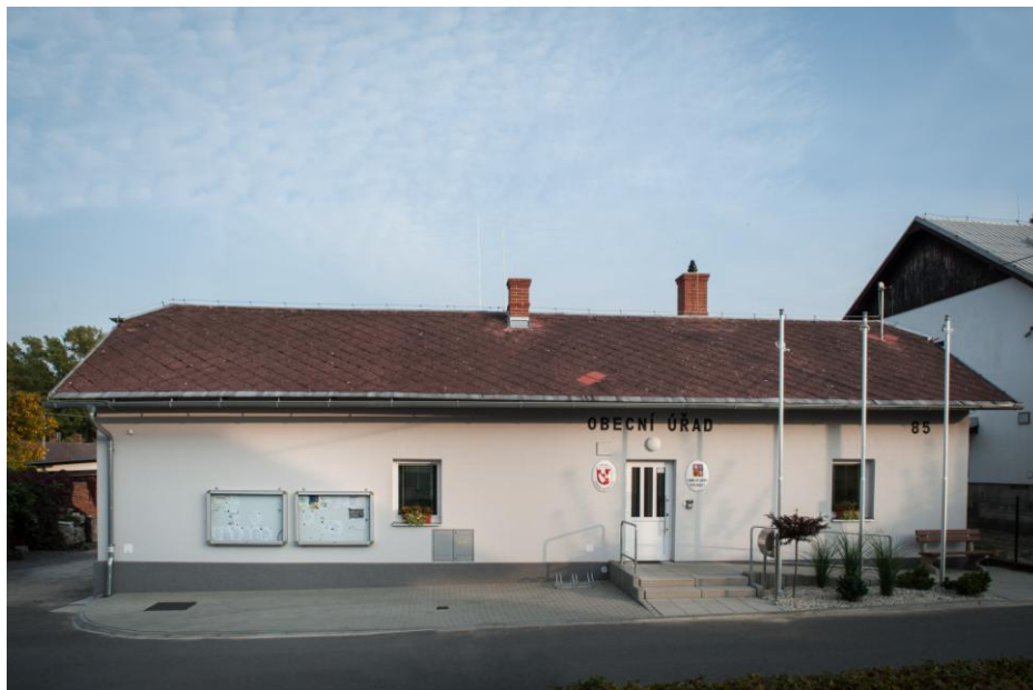
Obecní úřad v Nových Sedlicích po rekonstrukci – podzim 2015
